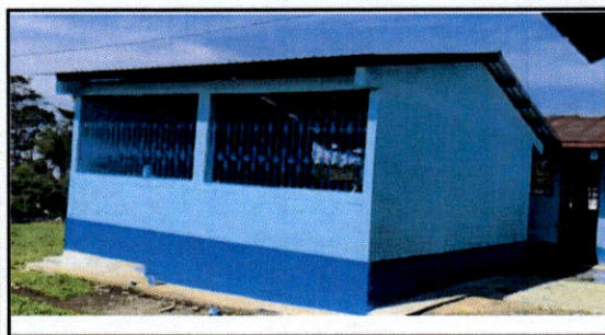
FOTO 5: Reparación de muro perimetral de block.
